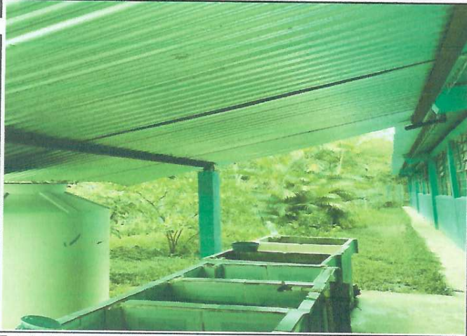
Foto 1: Mejoramiento de cocina, estructurada y techado de lamina troquelada calibre 26.
